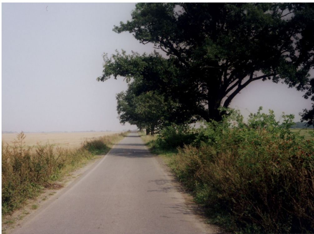
Zdjęcie nr 9 – Nowa droga o nawierzchni asfaltowej do wsi Wyskok (dz. nr 90)
